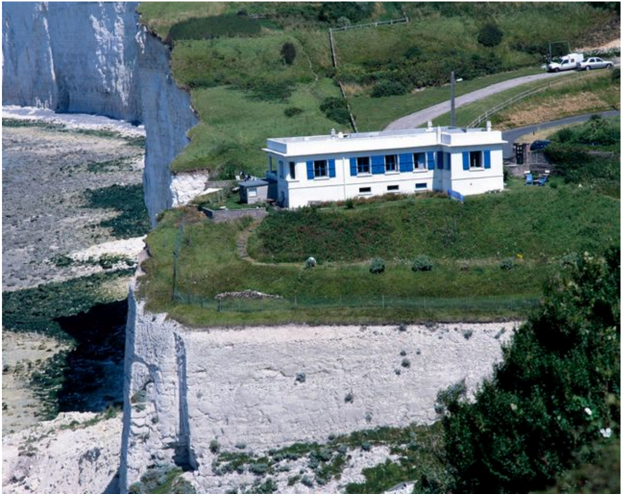
Vue d'ensemble, état actuel.
