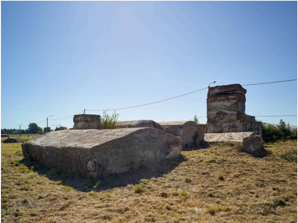
Vue postérieure des casemates a à f (premier plan) vers le sud-est.
