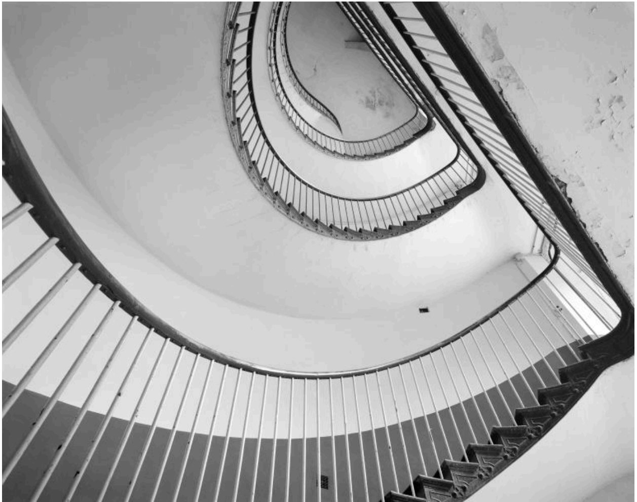
Vue d'une cage d'escalier de l'aile droite.
