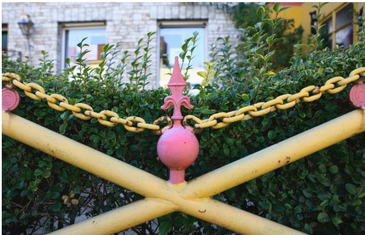
Façade sur rue, détail de la clôture.
