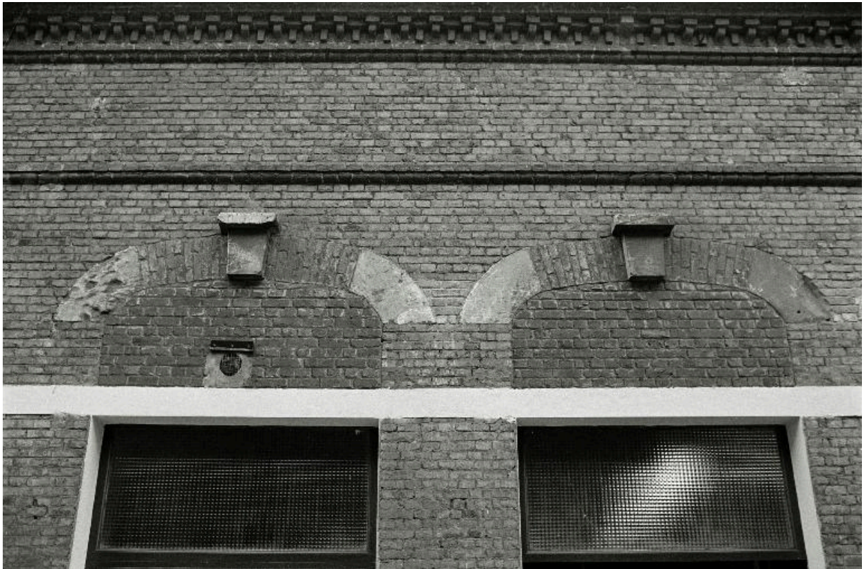
Detail de baies de l'atelier de fabrication, en 1990.
