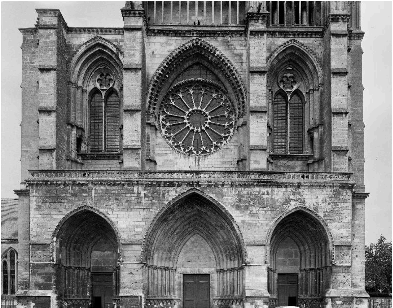
Façade occidentale : vue des deux niveaux inférieurs.
