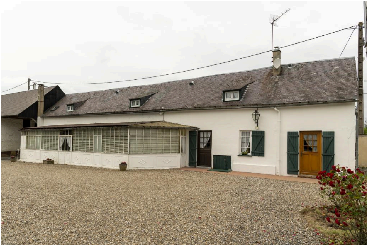
Logis avec véranda, vue de la façade sud depuis la cour.
