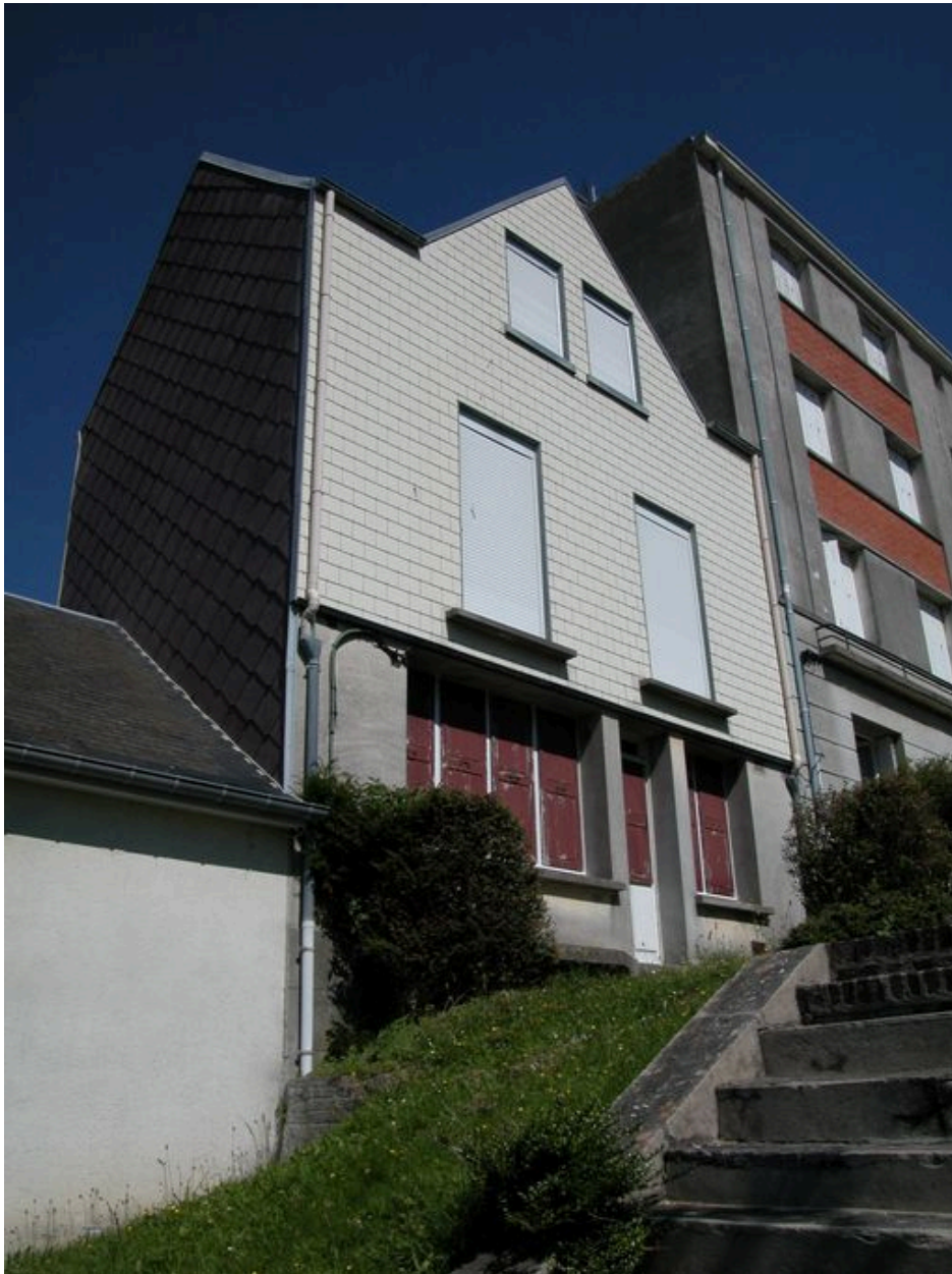
Maison, 21 avenue du Casino (1983 AB 139).
