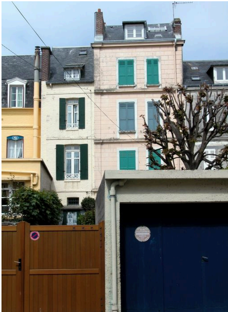
Elévations postérieures des maisons La Violette et la Vague, rue Henri-Leboeuf.
