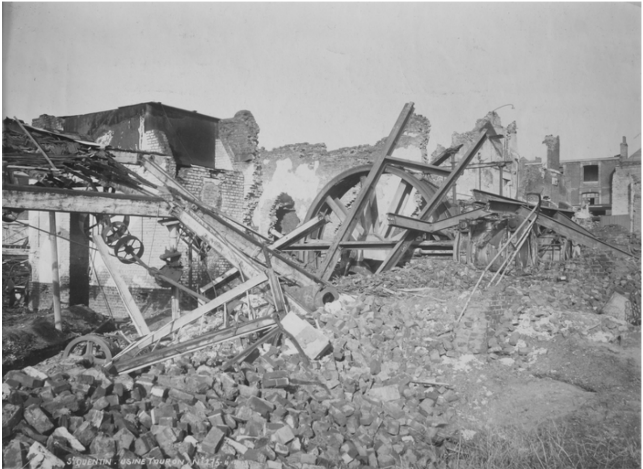
Le site de la filature en avril 1919 : la salle des machines (AD Aisne).
