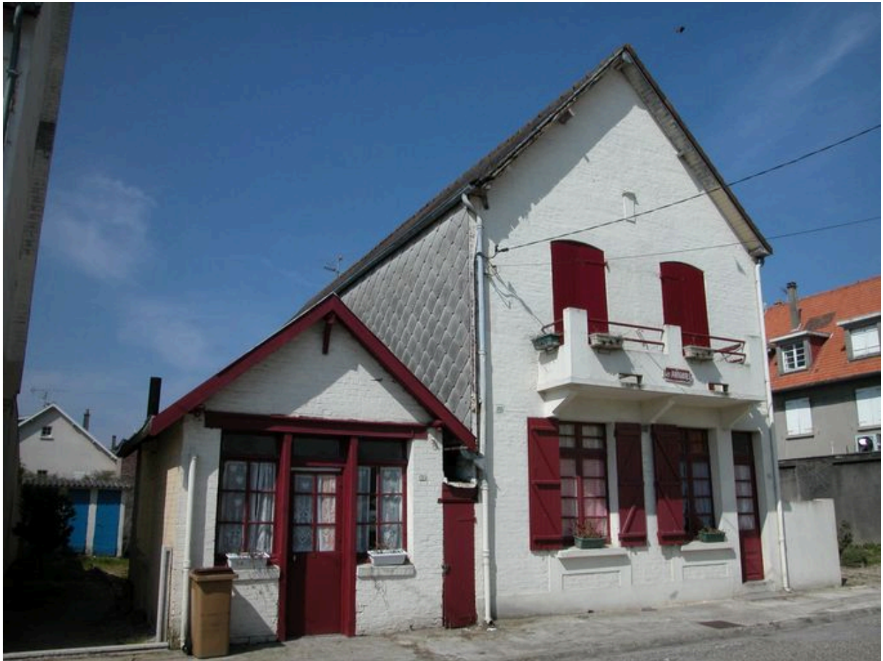
Vue d'ensemble de l'édifice et de son ancienne dépendance.
