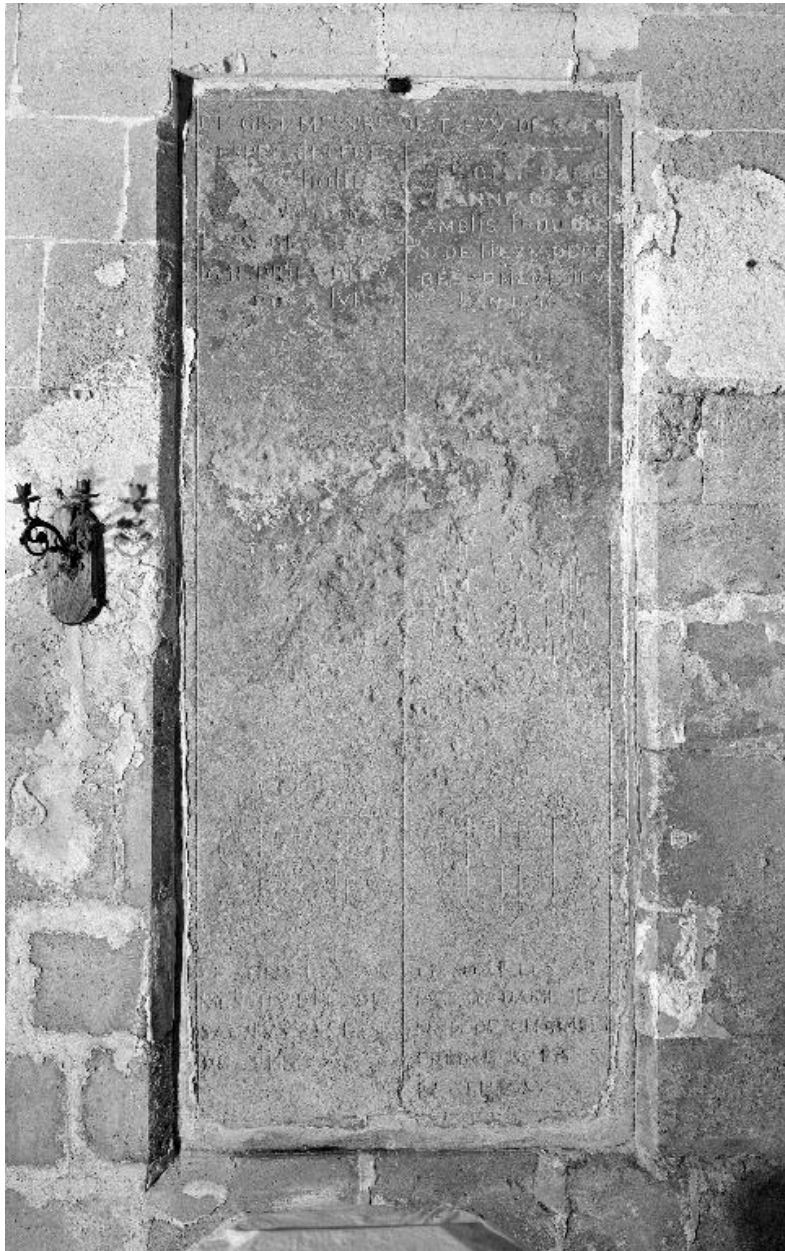
Vue générale de la dalle.
