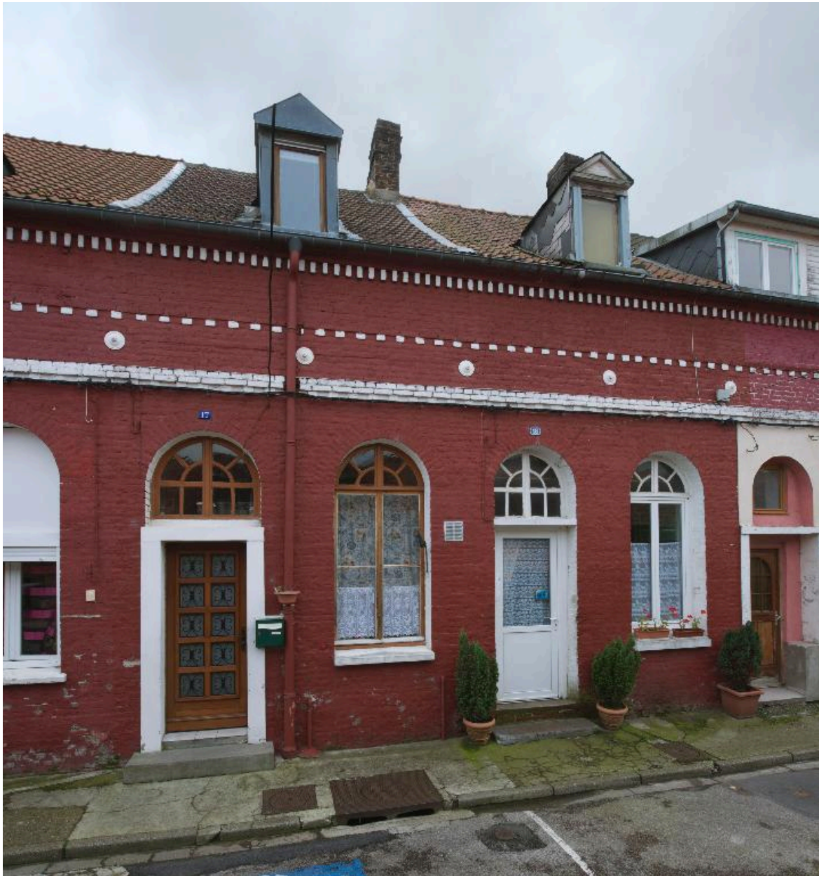
Façade sur rue des logements 17 et 18 de la cité Saint-Jules.
