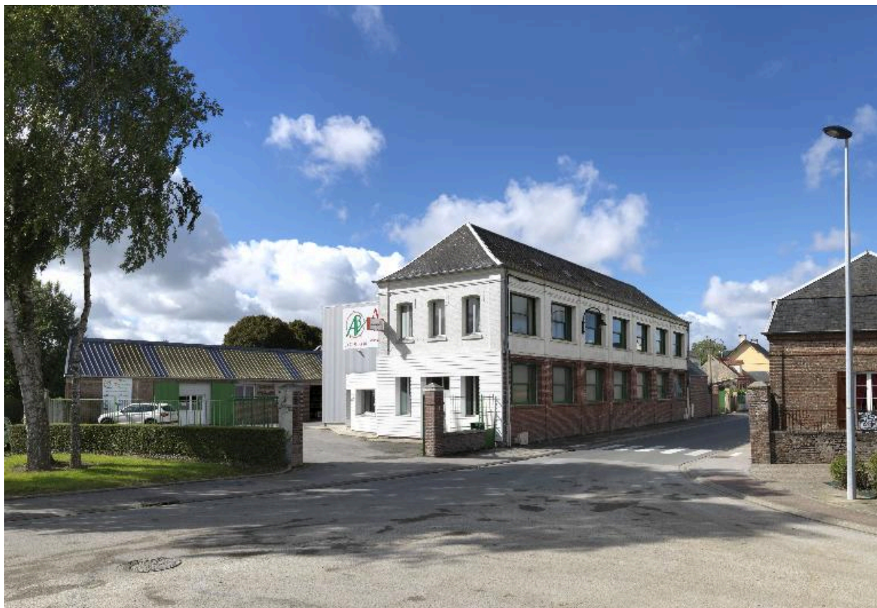
Vue générale de l'atelier de fabrication construit en 1888.
