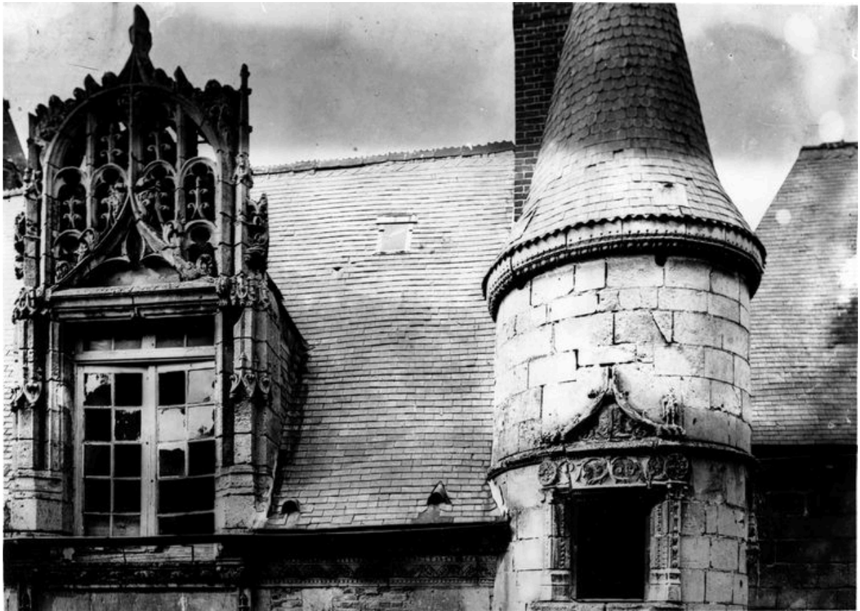
Détail de la tourelle d'angle et d'une lucarne, avant 1914 (AP).
