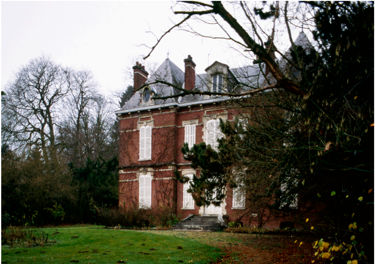
Vue de la façade.
