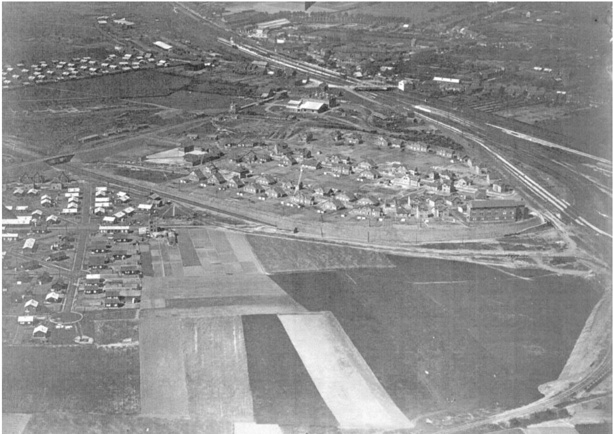
Photo aérienne de la cité de cheminots avant son achèvement. Photographie ancienne, photographe inconnu, vers 1925 (ANMT Roubaix, 202 AQ 1189).
