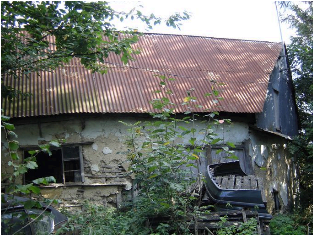
Vue du bâtiment au sud qui semble avoir été une étable depuis la cour.
