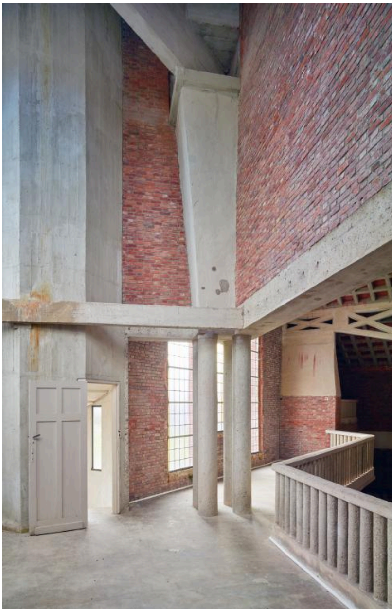
Élément de charpente depuis la tribune.
