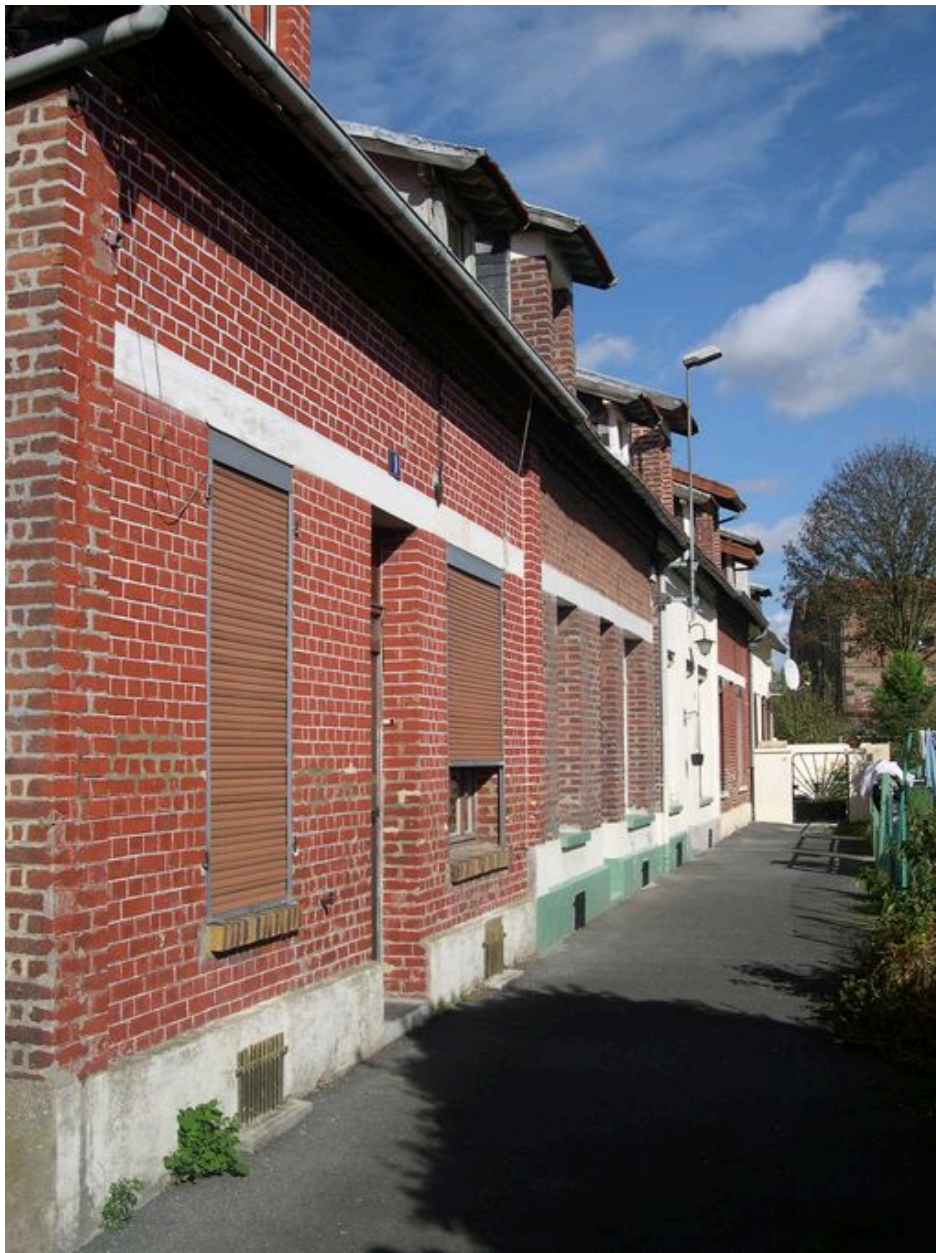
Cité Saint-Jean, maisons construites en 1921.
