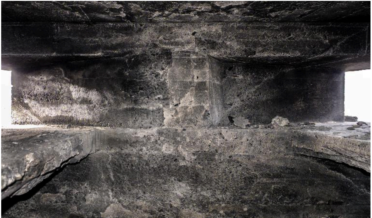
Vue intérieure : Banquette de tir nord et embrasures nord-ouest et nord-est
