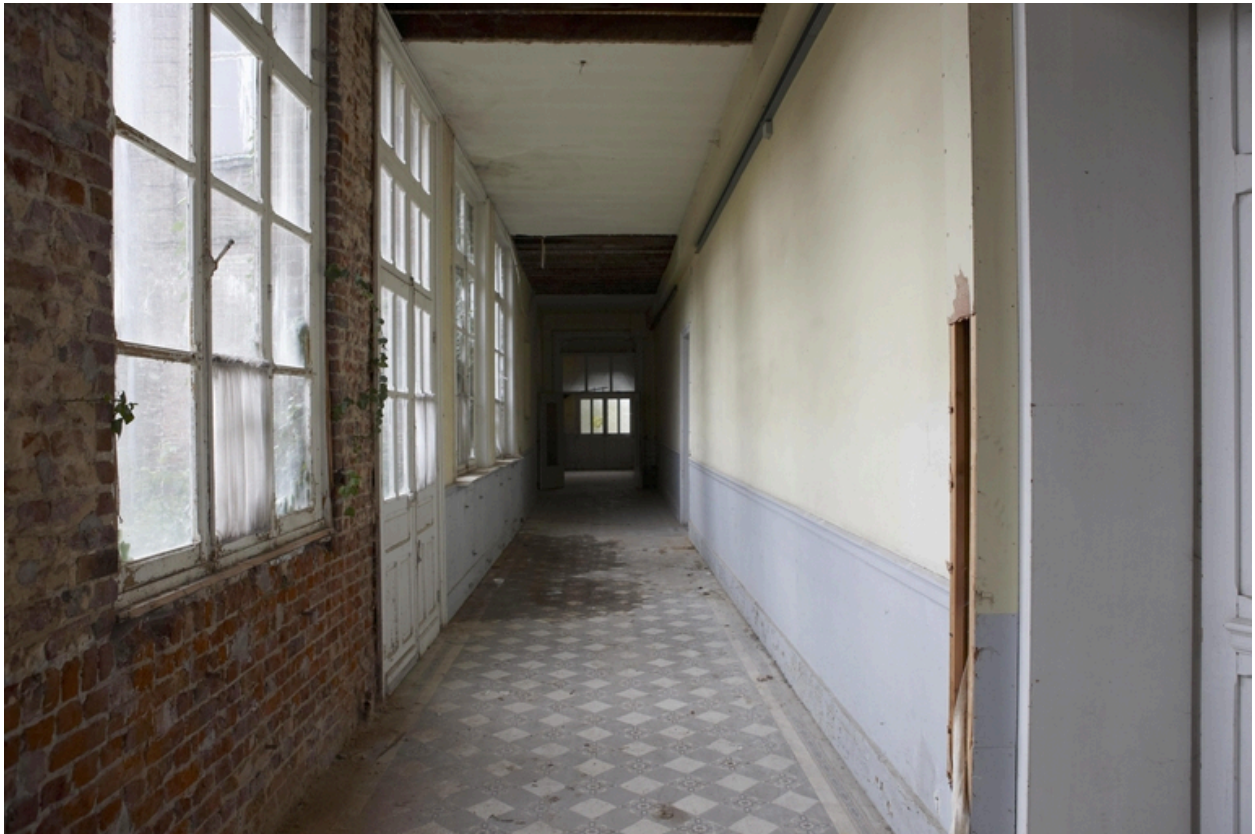
Le couloir reliant les ailes.
