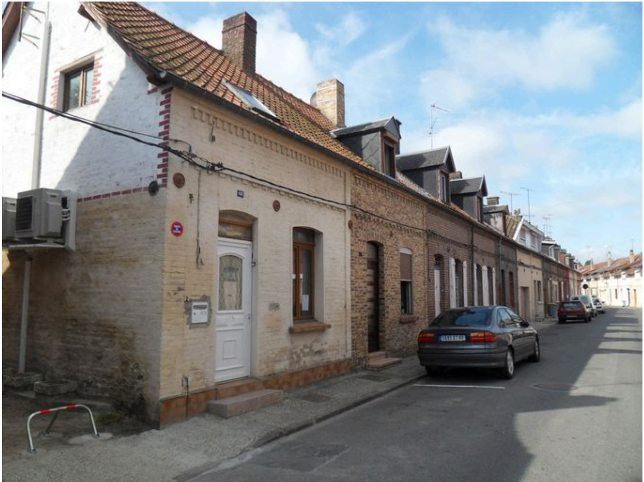
Vue des logements, rue Docteur-Jean-Martin (rive sud).
