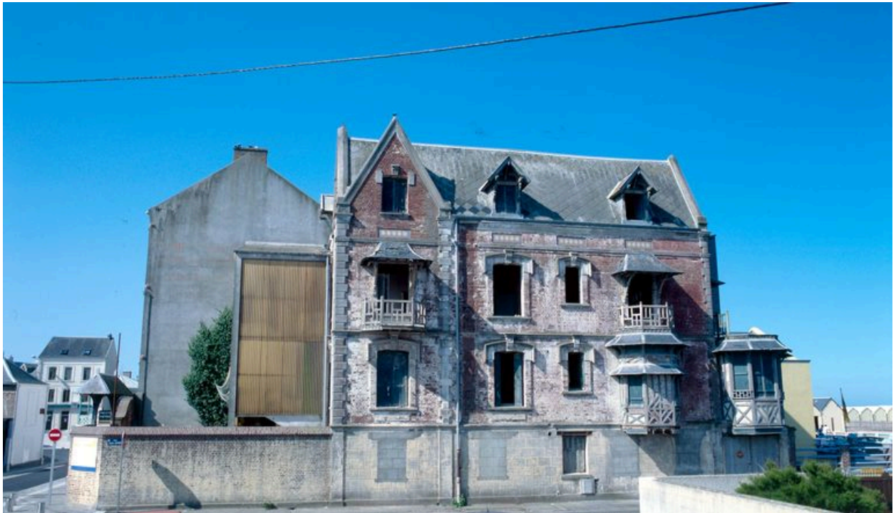
Vue de la façade sur la rue Jules-Dupré.
