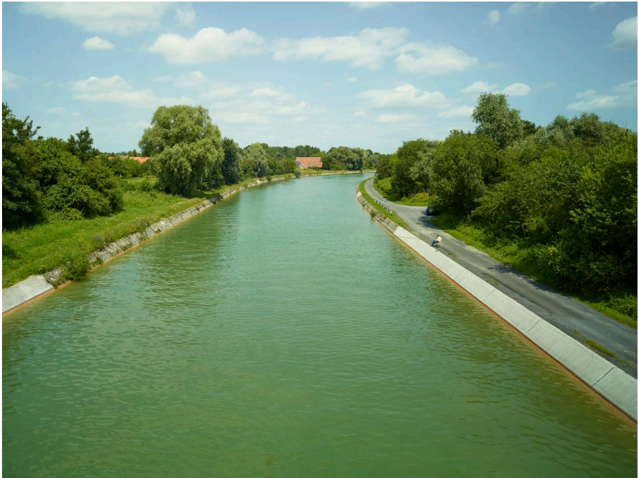
Vue depuis le pont en amont du site.
