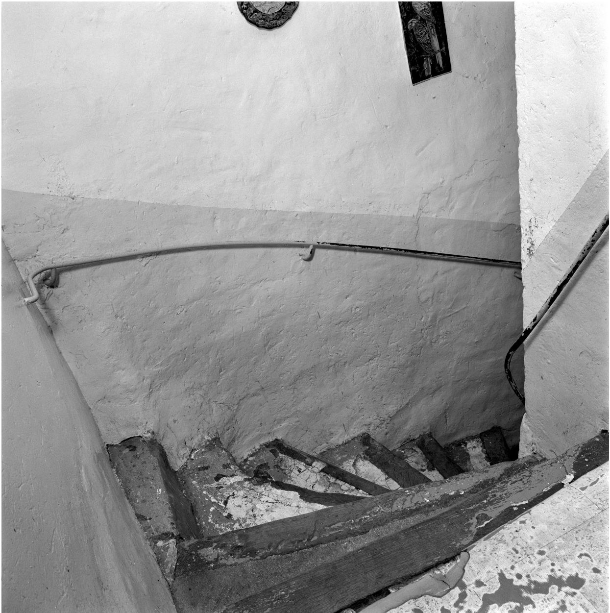
Vue de l'escalier.
