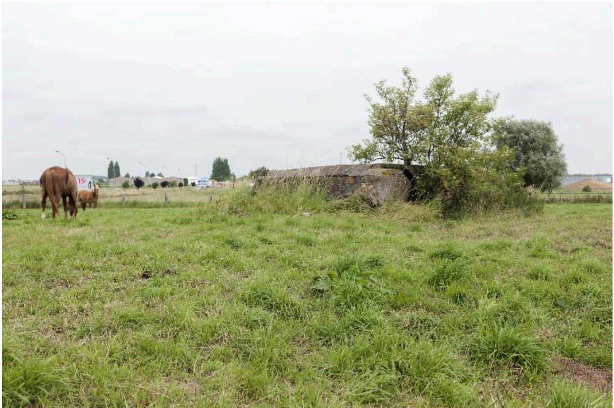
Casemate a, vers le nord-est
