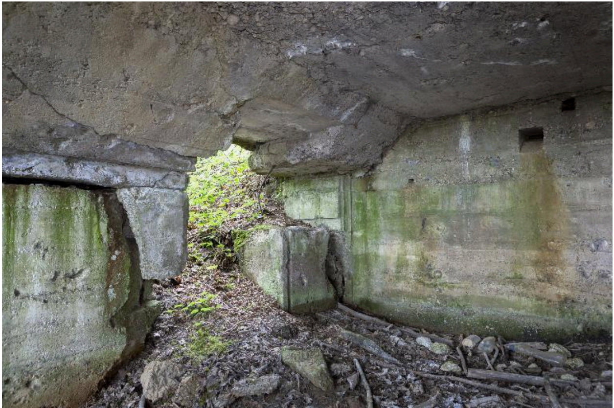
Casemate n°2, Vue intérieure
