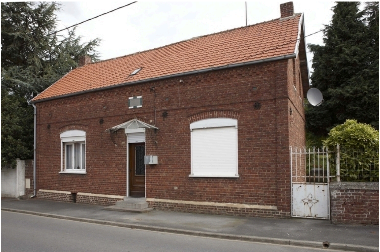
Vue d'une maison datée 1924, située 20 Grand'Rue.
