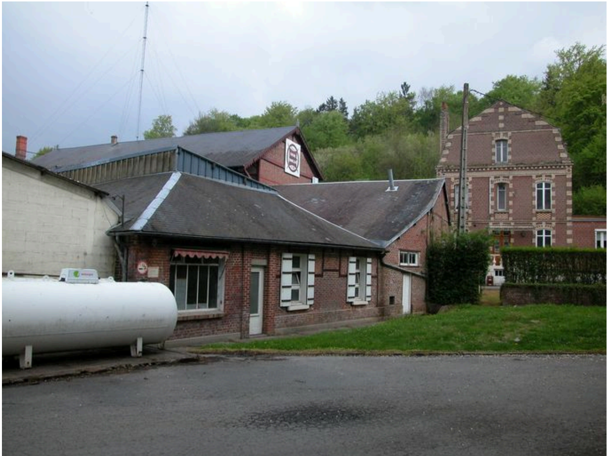
Vue d'ensemble des ateliers et du logement de directeur.
