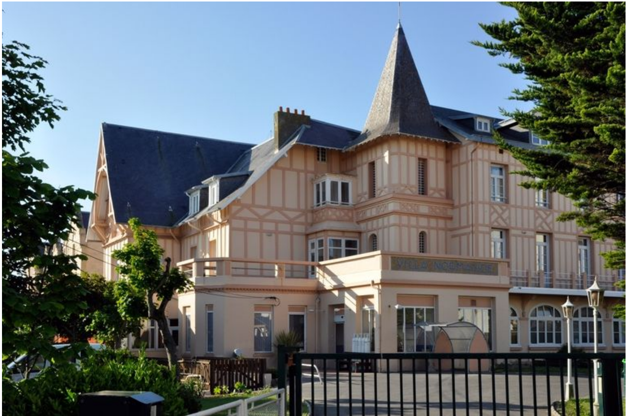
Vue générale, élévation rue Eugène-Trigoulet, en 2010.
