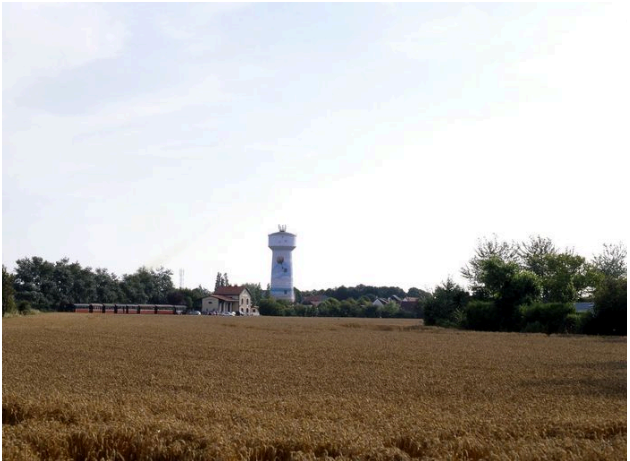
Vue d'ensemble depuis la route D 260.
