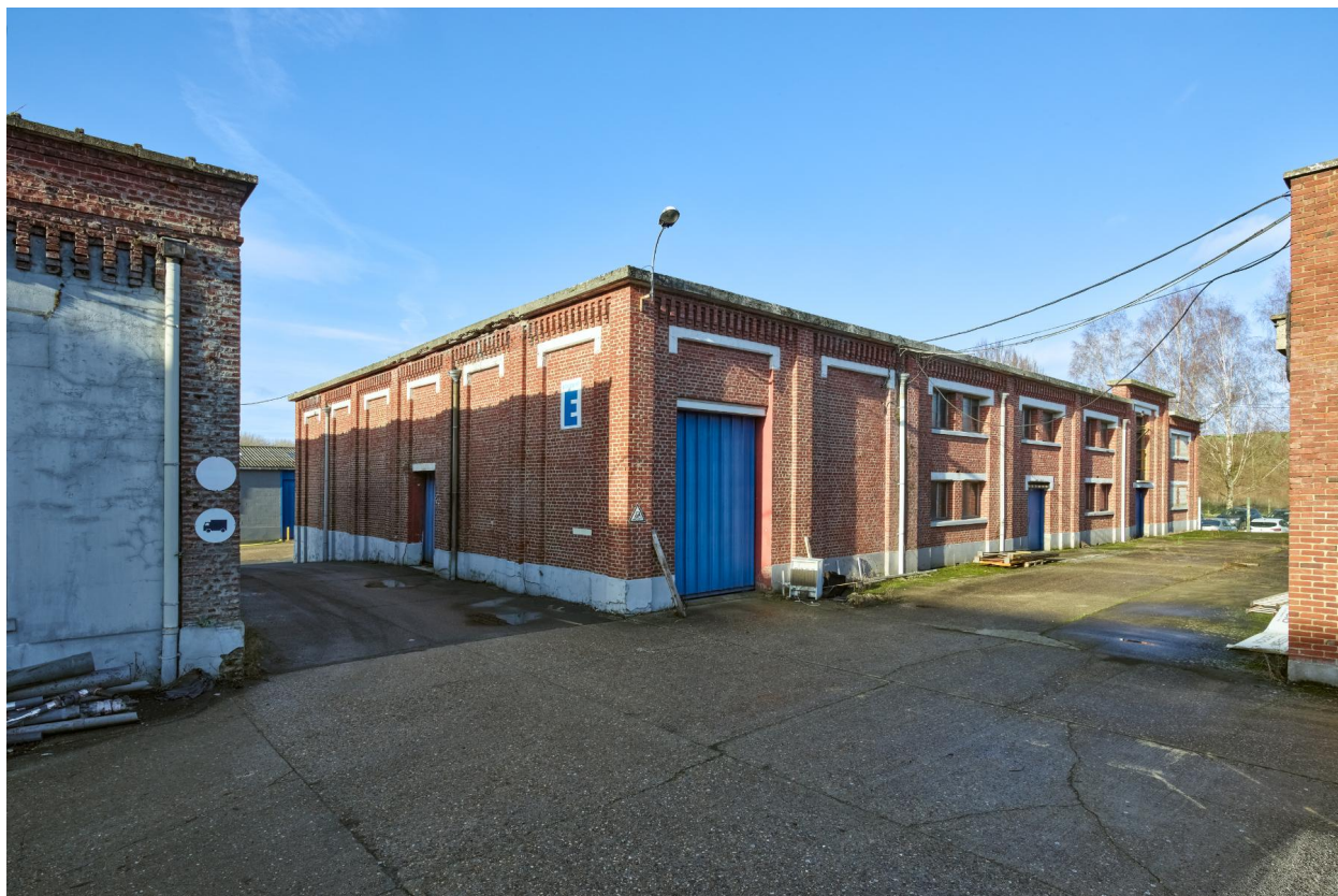
Vue d'ensemble sud-est des entrepôts (bâtiment E).
