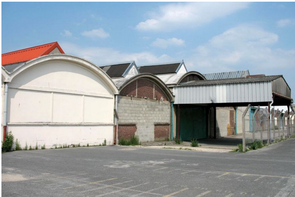
Détail des ateliers de montage.
