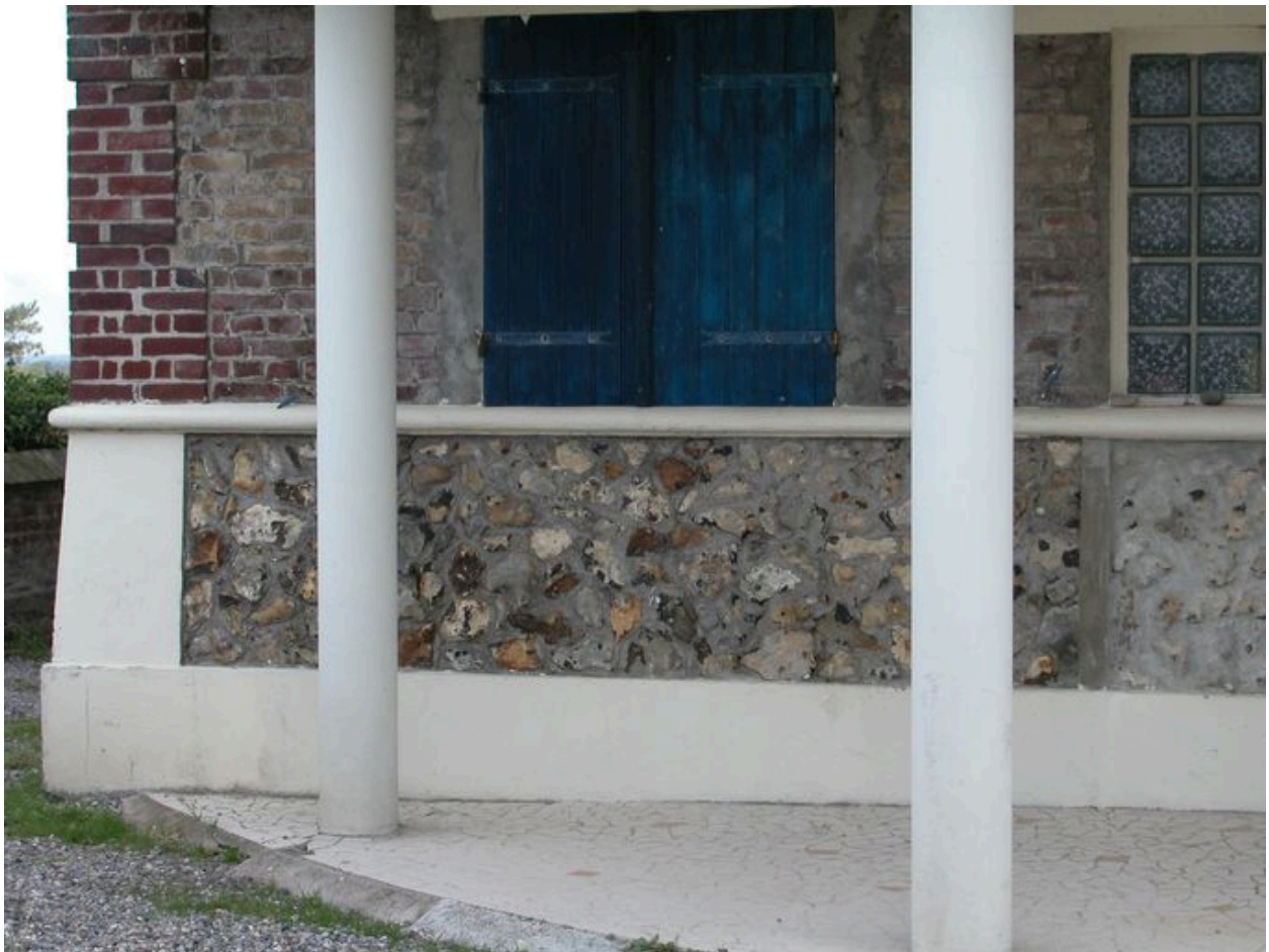
La base du mur de la villa Le Phare, avec gros rognons de silex, 110 rue du Général-Leclerc (1988 AB 36).
