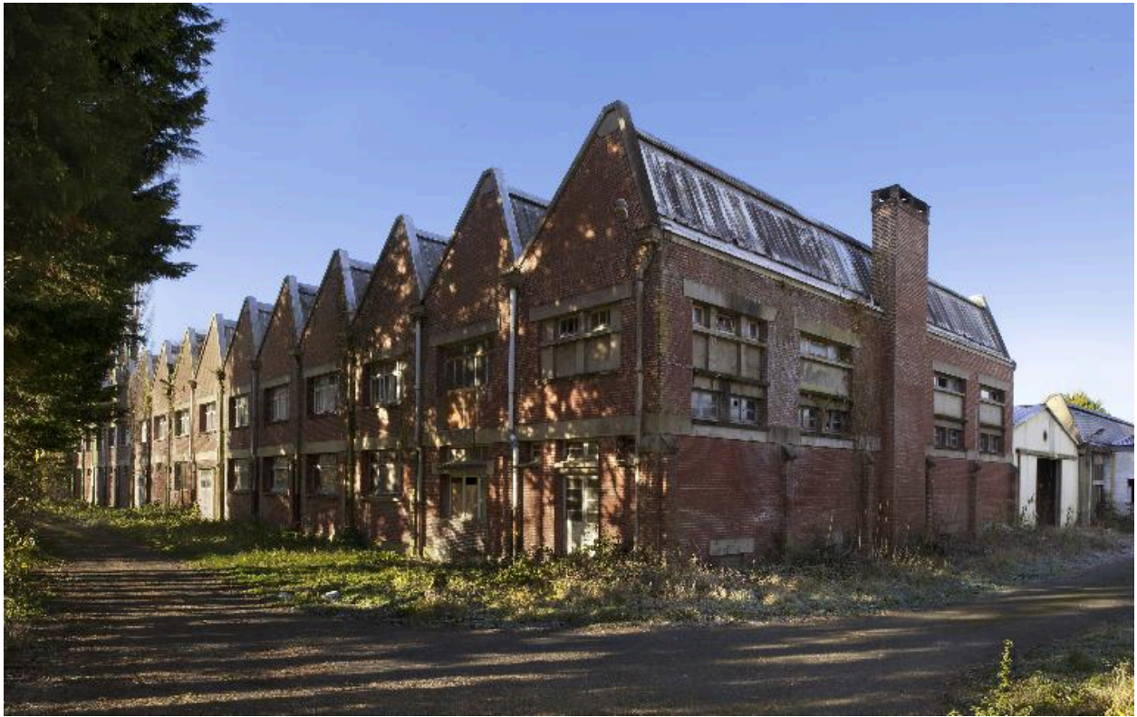
Entrepôt de matières premières et atelier de confection, vue depuis l'est.
