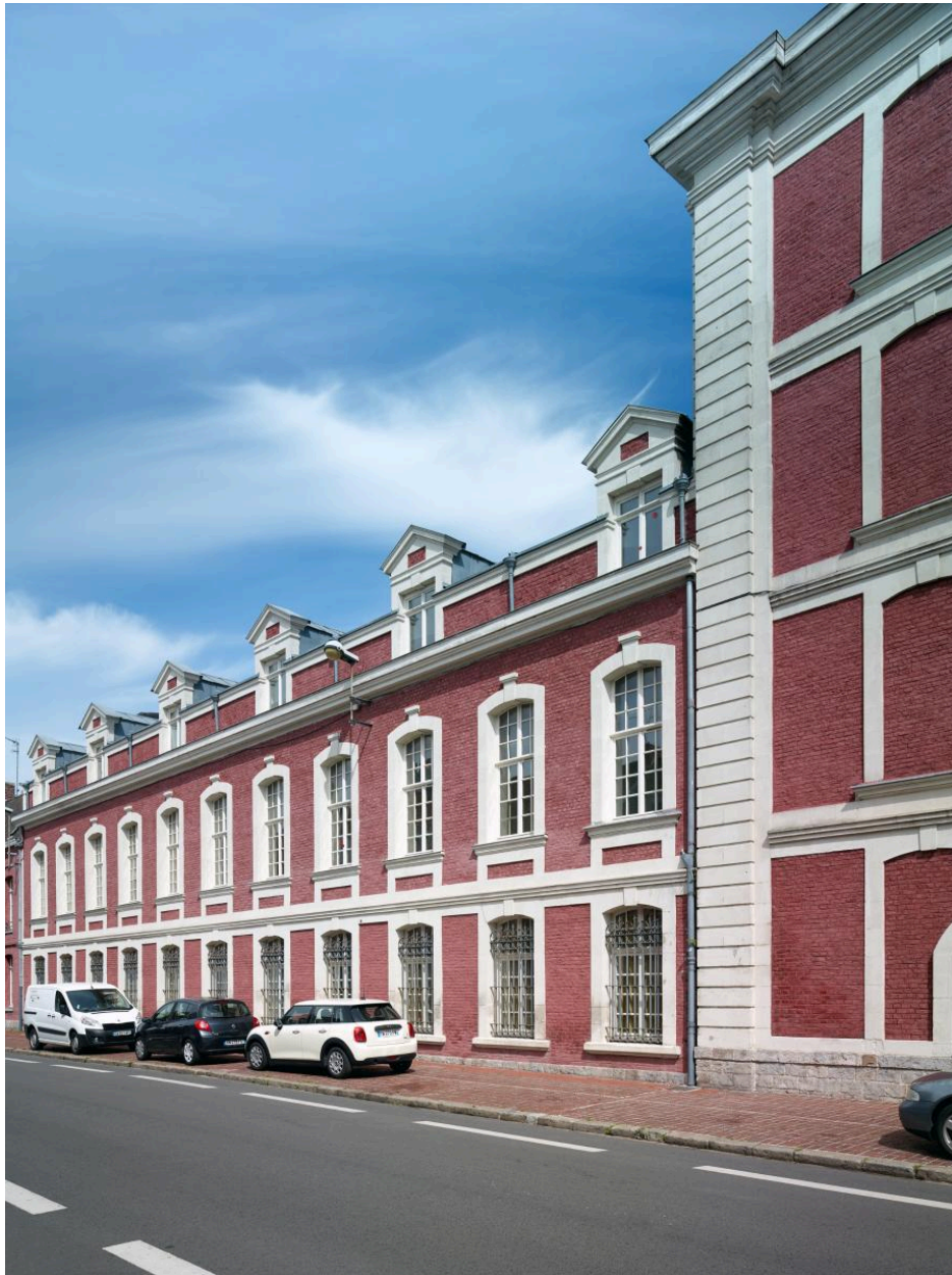
Façade le long de la rue Saint-Albin (partie construite en 1832). Vue orientée ouest-nord.
