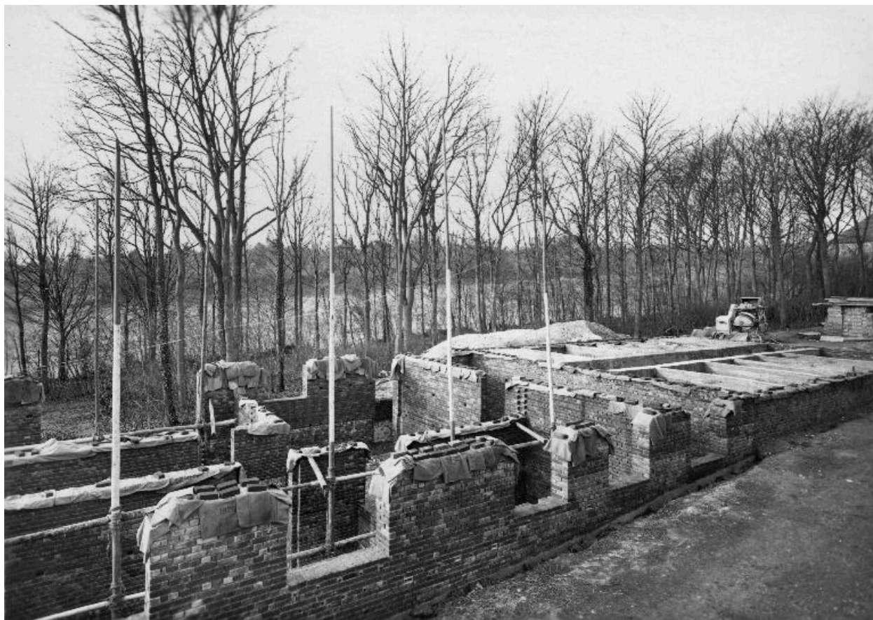
Soubassement de la maternité en cours de construction, 1937.
