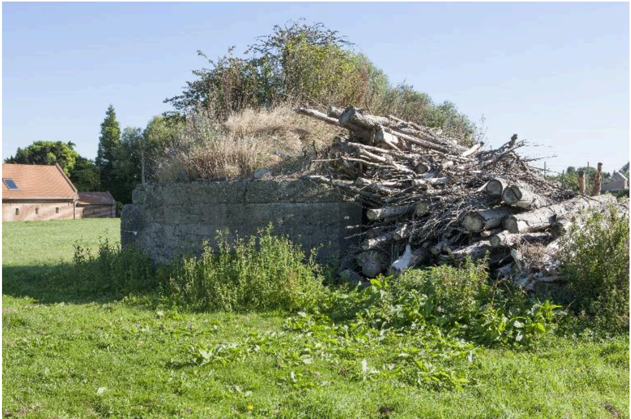
Vue vers le nord-est
