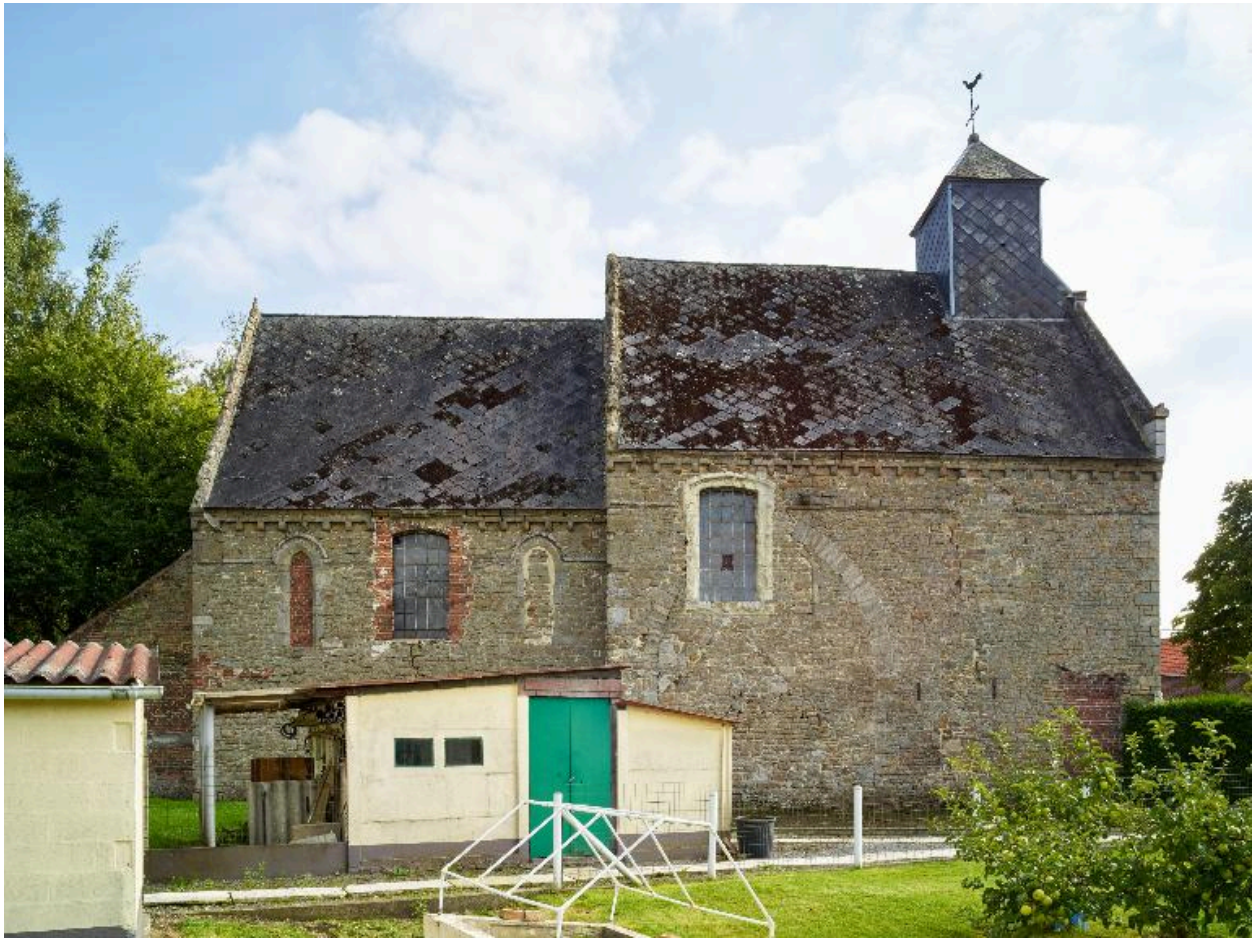
Vue générale de la façade méridionale.
