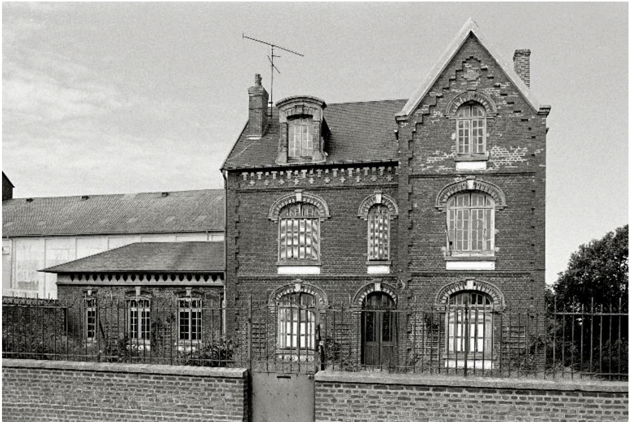
Vue générale depuis la rue en 1990
