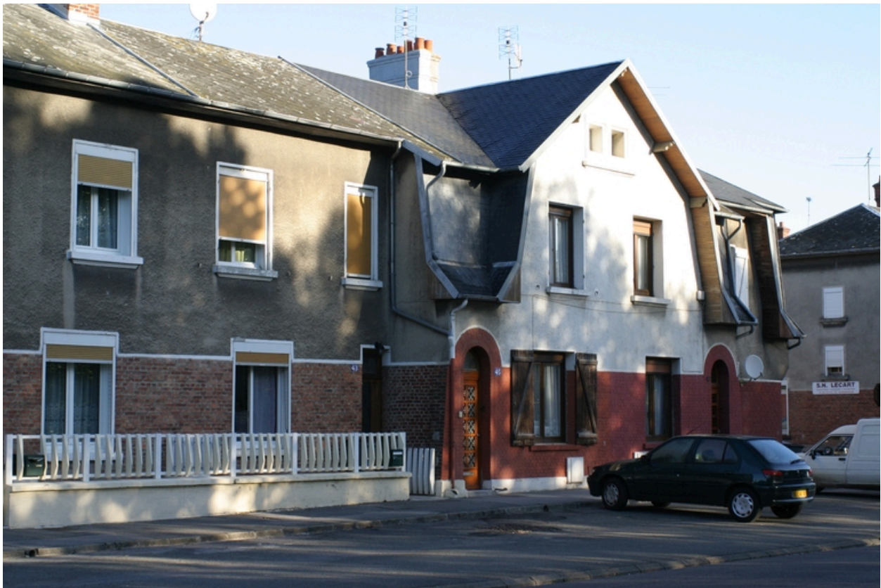
Les logements ouvriers de types C (n°43), B (n°45 et 47) et D (à l'angle).
