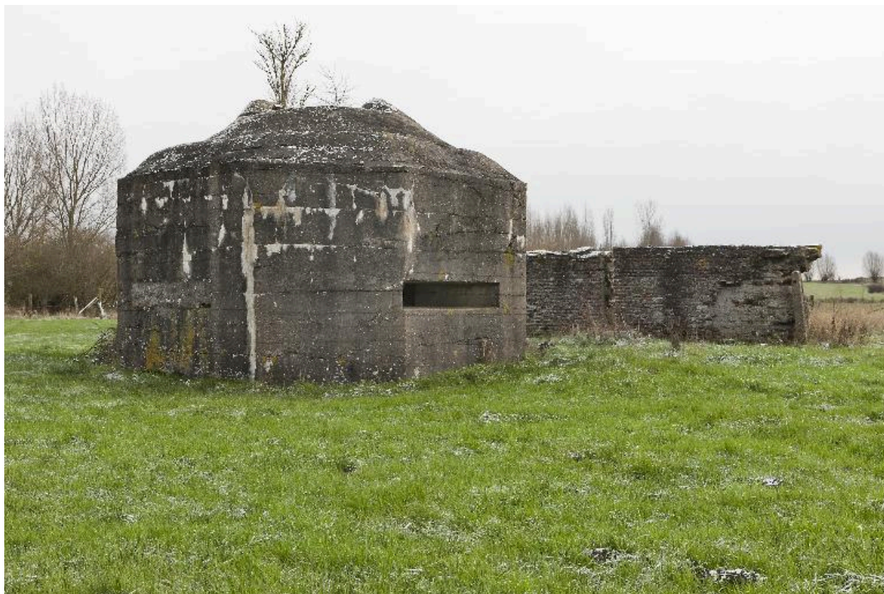
Casemate nord, vue vers le sud-sud-est
