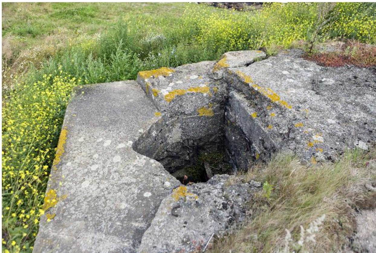
Logement de l'observatoire cuirassée, vers le nord
