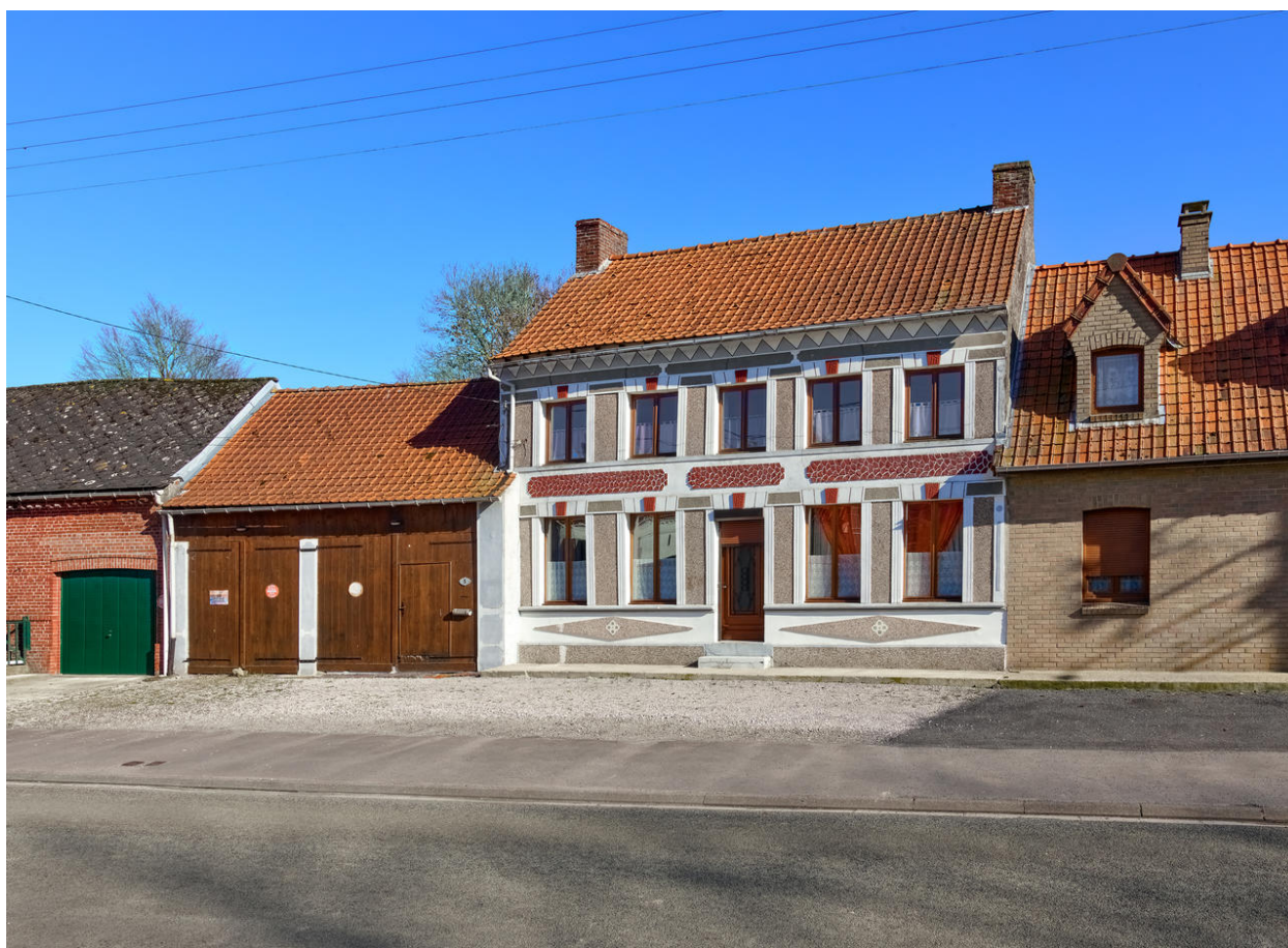
Maison, rue du Moulin.
