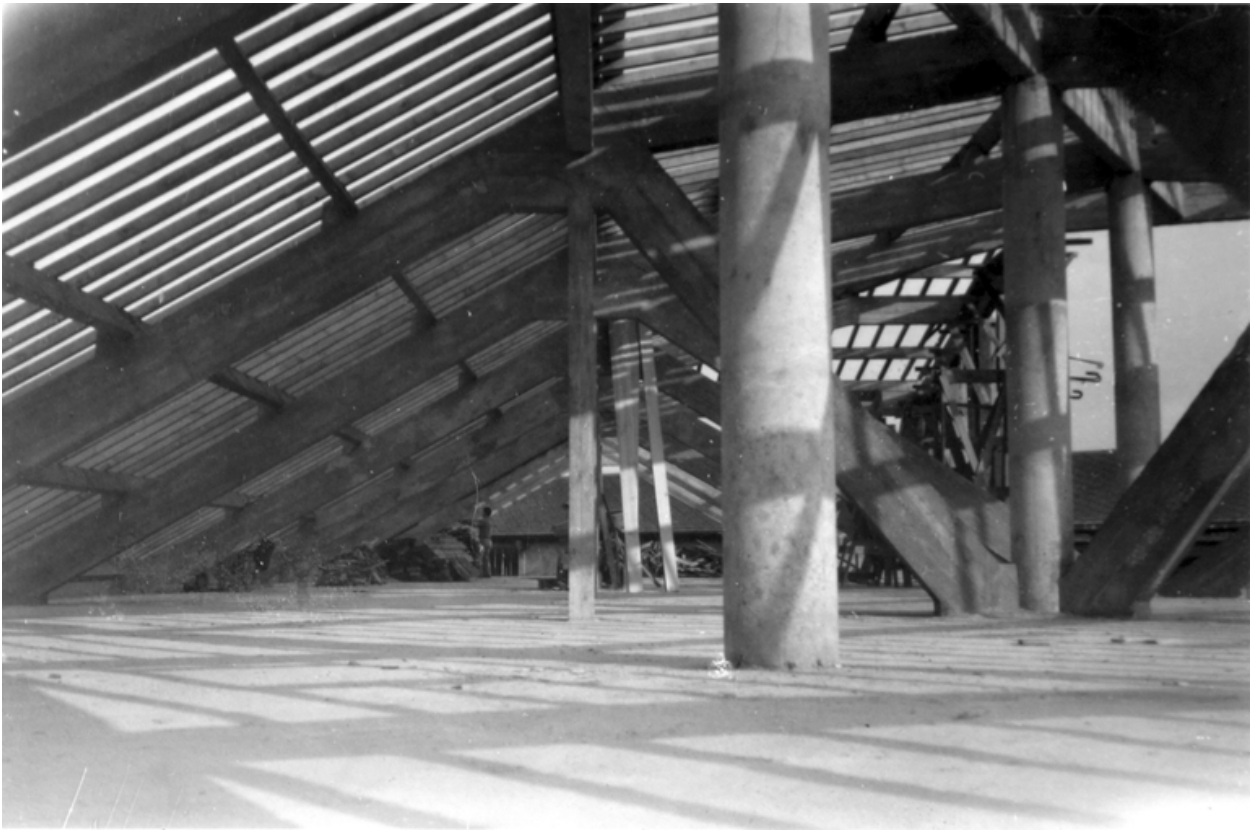
Charpente des ateliers construits en 1948 (IFA).
