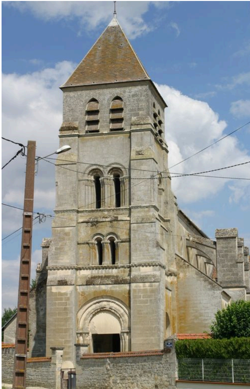
Vue d'ensemble de la façade occidentale.
