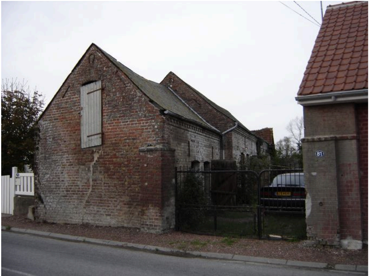
Vue des étables, écuries et porcheries.
