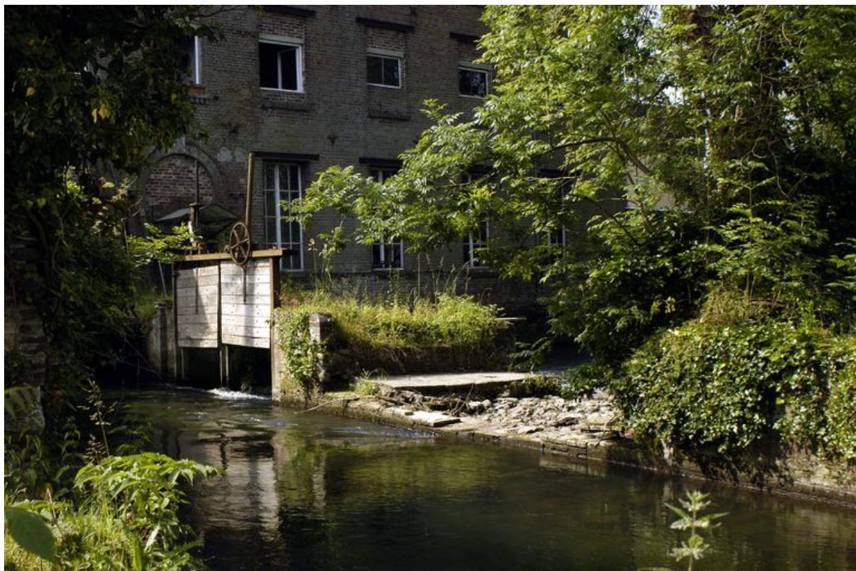
Le déversoir et le vannage de décharge.
