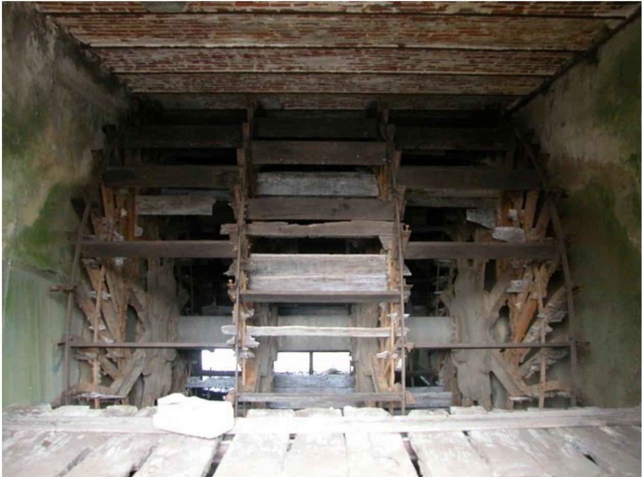
La roue hydraulique, vue de face.
